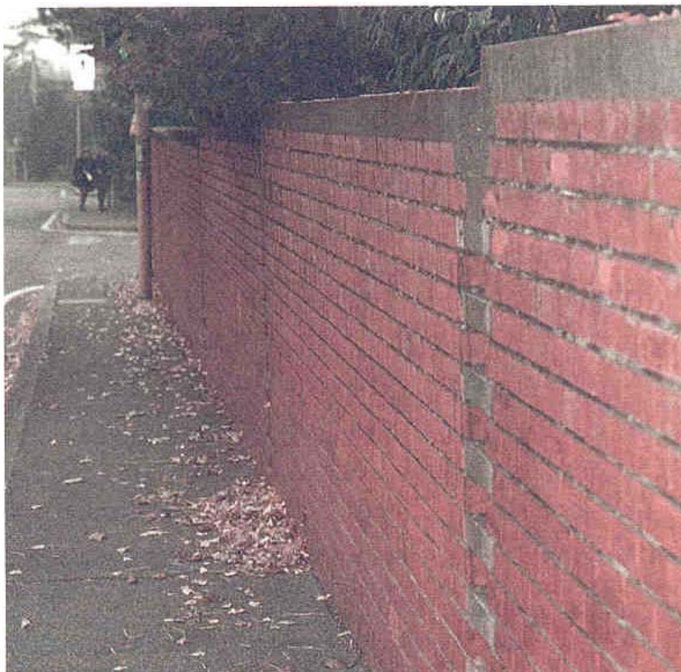
Fig.11 – Muretto di recinzione con giunti ogni 4 metri.....
