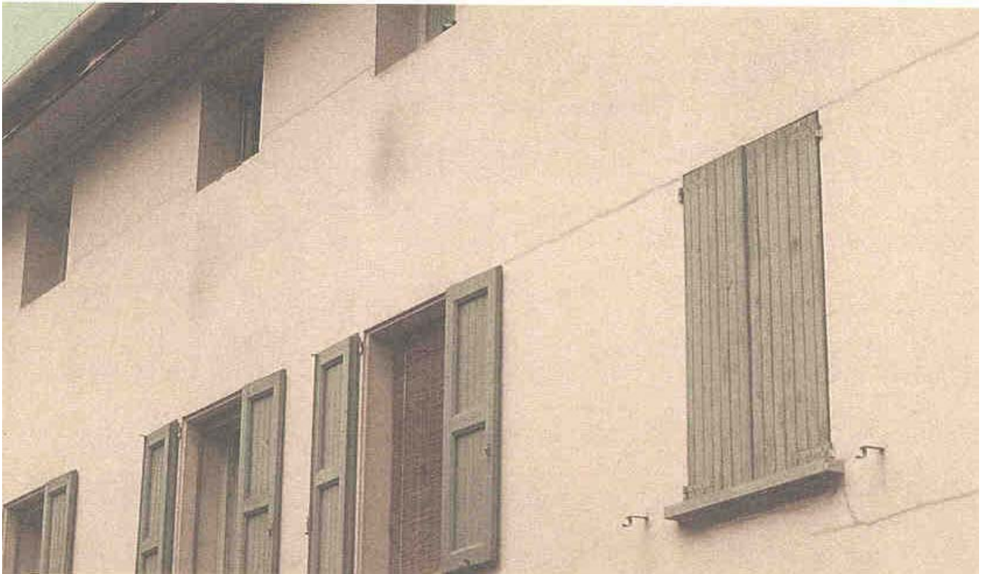
Fig.2 – La fessurazione in corrispondenza dell'architrave delle finestre.
