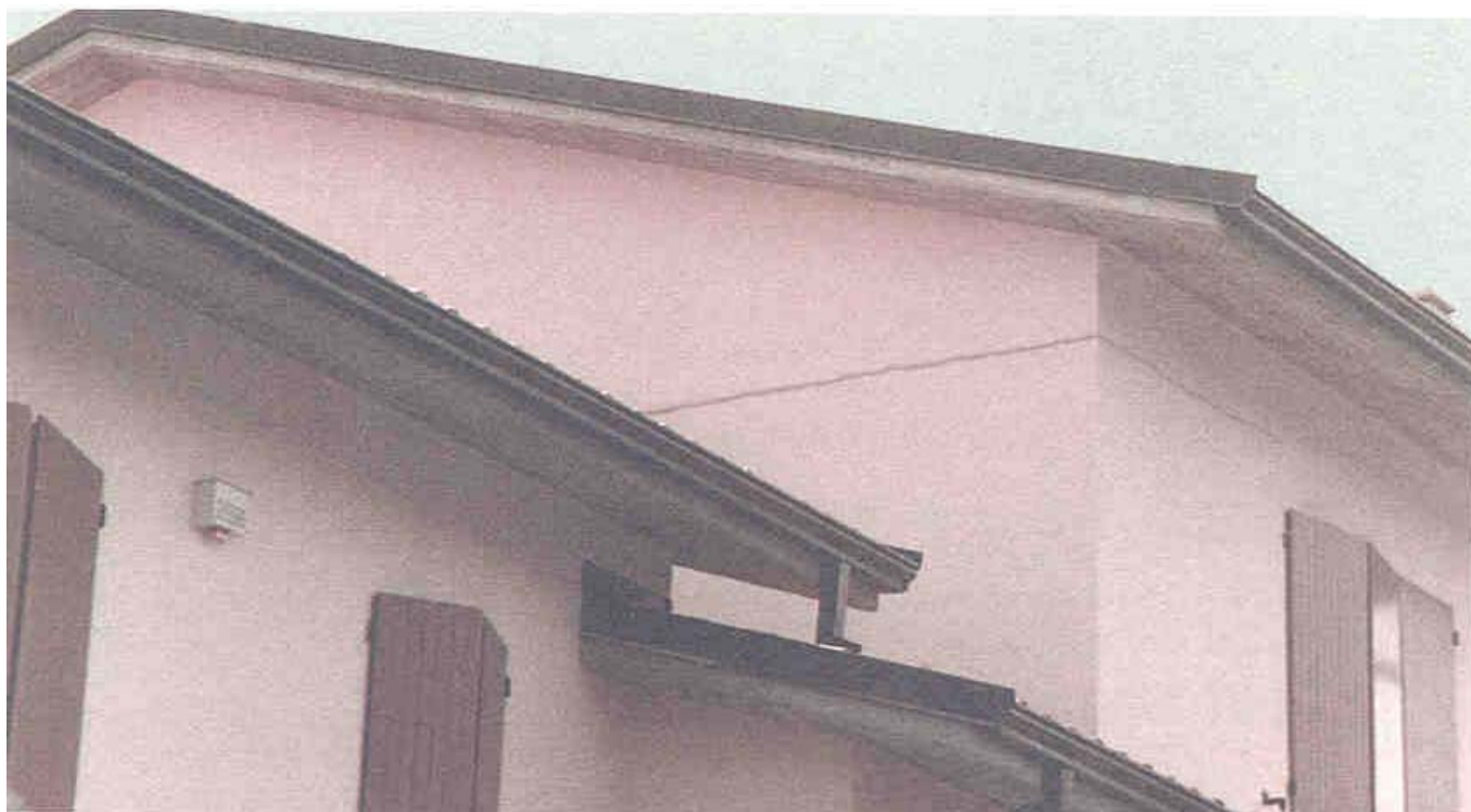
Fig.1 – La fessurazione in corrispondenza del cordolo di solaio.
